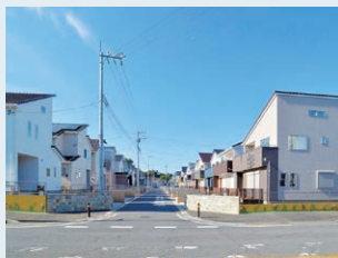
セレクトタウン印西牧の里 [全87棟]
